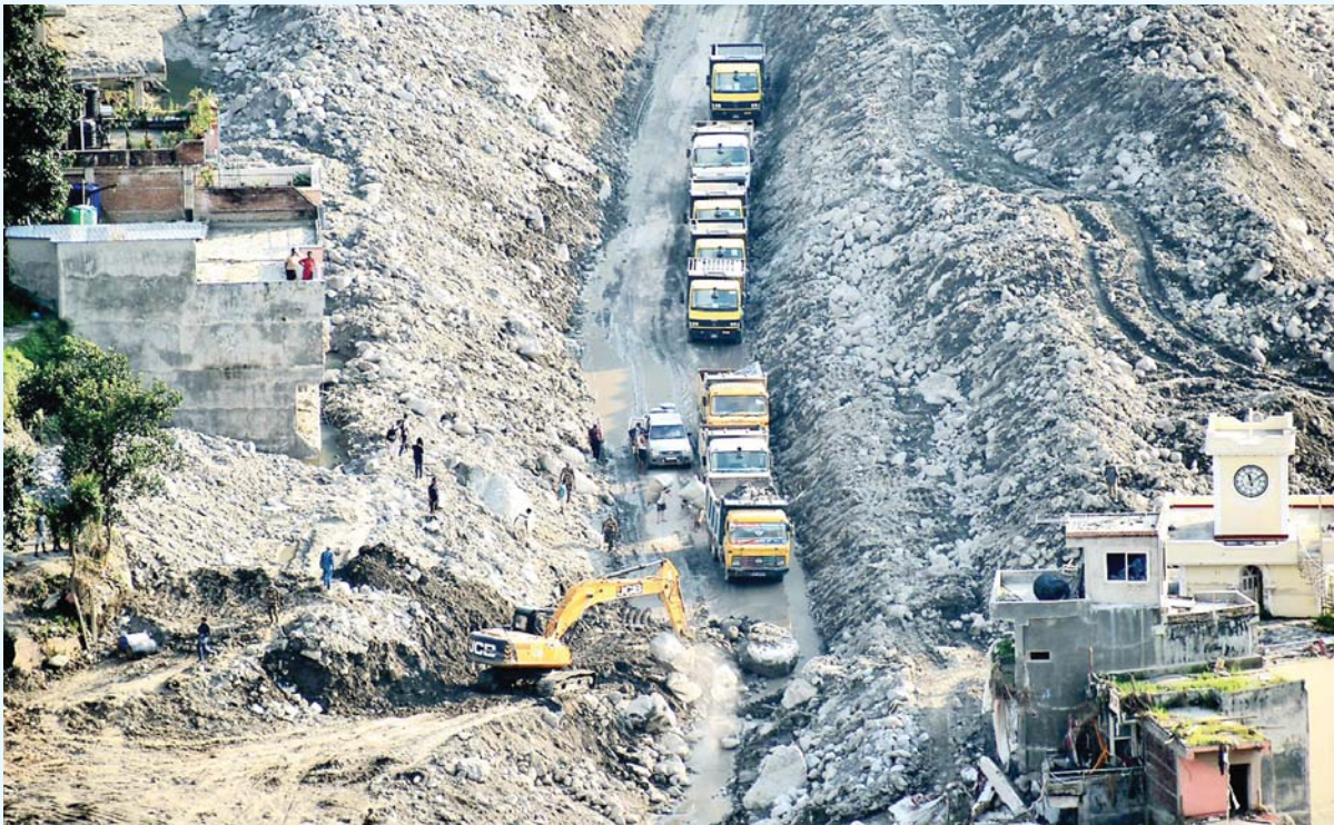
अस्थायी ट्याक सोलिादै रसुवा बाढीबाट क्षतिग्रस्त गल्ली-वेत्रावती सडकखण्डमा डोजरको सहयोगमा अस्थायी ट्याक खोल्दै । तस्विर: रासस
