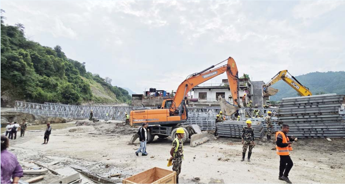
बेलीब्रिज जडान गरिँदै | नुवाकोटको देवीघाट बजारस्थित तादी नदीमाथि बेलिब्रिज जडान गर्दै नेपाली सेना । भदौ १० को भोटेकोशी बाढीले पुल बगाएपछि शनिबारदेखि बेलिब्रिज जडान गर्न सुरु गरिएको हो । तस्विर: रासस
