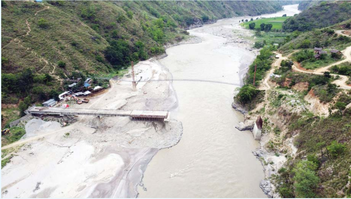
निर्माणाधीन लुमुघाट पुल | तेह्रथुम र पाँचथर जोड्ने तमोर नदीमा निर्माणाधीन लुमुघाट मोटरबल पुल । १३ वर्षअघि निर्माण सुरु भएको पुल अझै निर्माण सम्पन्न हुन सकेको छैन । तस्विर: रासस
