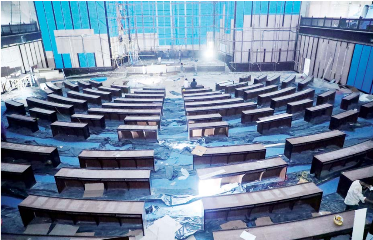
सिंहदरबारमा निर्माणाधीन संघीय संसद् प्रतिनिधिसभाको बैठक कक्ष । यही जेठ १५ गते हुने आर्थिक वर्ष २०८३/८४ को बजेट भाषण यही नयाँ सभा कक्षबाट गर्ने तयारी गरिएको छ ।
