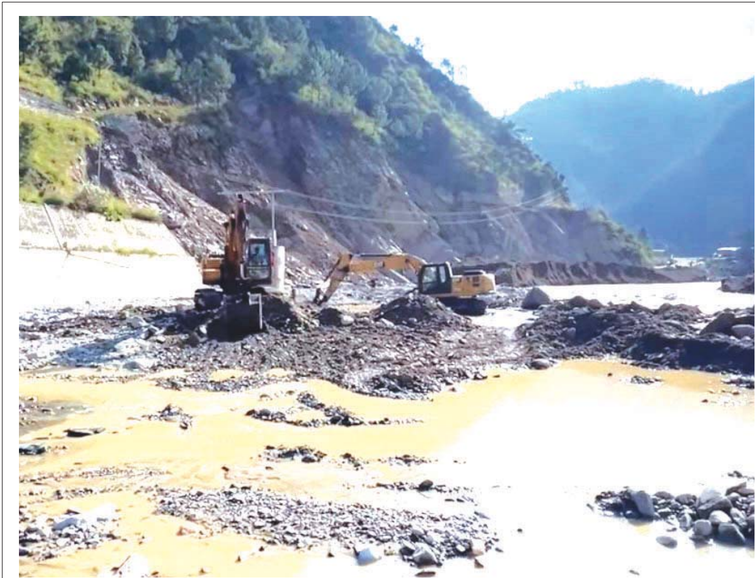
डाइभर्सन बनाइँदै गत साता रोशी खोलाको बाढीले बिपी राजमार्गको विभिन्न स्थानमा सडक कटान गरेपछि अस्थायीरूपमा सडक बनाउन काभ्रेपलाञ्चोकको नमोदुङ नगरपालिका-६ चौकीडाँडामा ‘डाइभर्सन’ निर्माण गरिँदै । तस्विर: रासस
