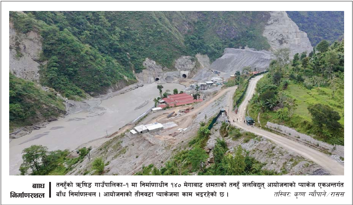
बाध निर्माणस्थल | तनहुँको ऋषिङ गाउँपालिका-१ मा निर्माणाधीन १४० मेगावाट क्षमताको तनहुँ जलविद्युत आयोजनाको प्याकेज एकअन्तर्गत बाँध निर्माणस्थल । आयोजनाको तीनवटा प्याकेजमा काम भइरहेको छ । तस्विर: कृष्ण न्यौपाने/रासस
