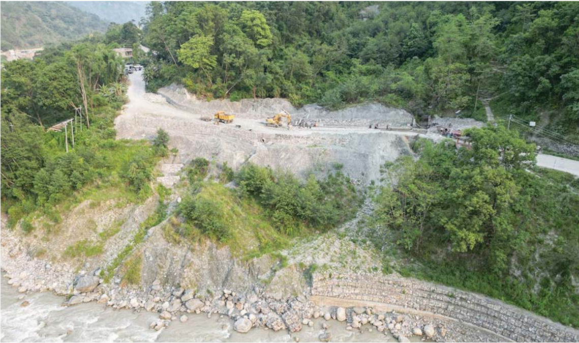
बागलुङ-बेनी सडक म्याग्दी र मुस्ताङलाई राष्ट्रिय राजमार्गसँग जोड्ने वैकल्पिक बागलुङ-बेनी सडकअन्तर्गत बेनी नगरपालिका-२ खवराको भसभसेमा सडक मर्मत गरिँदै । सडक डिभिजन कार्यालय बागलुङमार्फत करिब एक करोड ७० लाख रुपैयाँ लगानीमा निर्माण भइरहेको संरचना म्याग्दी र कालीगण्डकीको कटानको जोखिममा रहेकाले दिगोपनामा प्रश्न उठेको छ । तस्विर: सन्तोष गौतम/रासस
