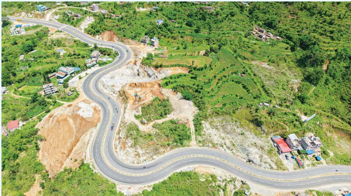
नागबेली सडक | पृथ्वी राजमार्गको मुग्लिन-पोखरा सडक विस्तार आयोजना (पूर्वी खण्ड) अन्तर्गत तनहुँको व्यास नगरपालिका-१२, कमलबारी र घाँसीकुवामा चार लेनमा विस्तार भएपछिको देखिएको नागबेली सडक । तस्बिर: सागर गिरी/रासस
