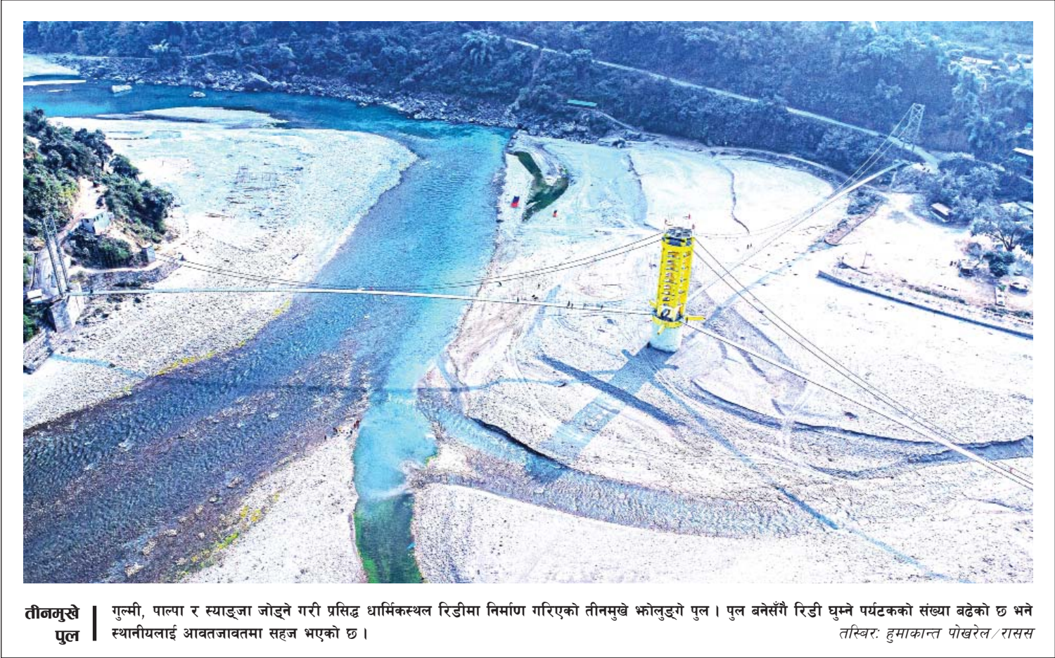
तीनमुखे पुल | गुल्मी, पाल्पा र स्याङ्जा जोड्ने गरी प्रसिद्ध धार्मिकस्थल रिडीमा निर्माण गरिएको तीनमुखे भोलुङ्गो पुल । पुल बनेसँगै रिडी घुम्ने पर्यटकको संख्या बढेको छ भने तस्विर: हुमाकान्त पोखरेल/रासस
